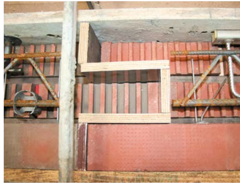
Fensterbank-Rollschicht Dämmung 3,0 cm
