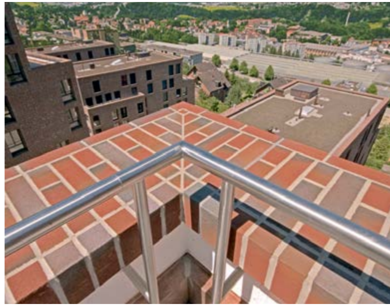
Ein Röben Fertigteile als präzise ausgeführte Mauerwerks-Abdeckung, individuell für das Objekt vom Röben Planungs-Service entwickelt und produziert. Hier als Balkon-Brüstung mit drei Sichtseiten.
