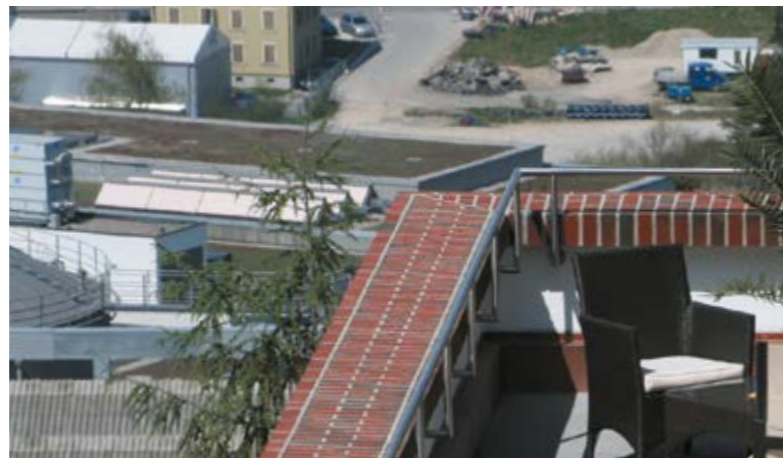
Keine Nahtstellen zu sehen: Die vorgefertigten Mauerwerks-Abdeckungen werden sowohl im Mauerverband als auch im Ziegel selbst perfekt in die Fassade integriert.
