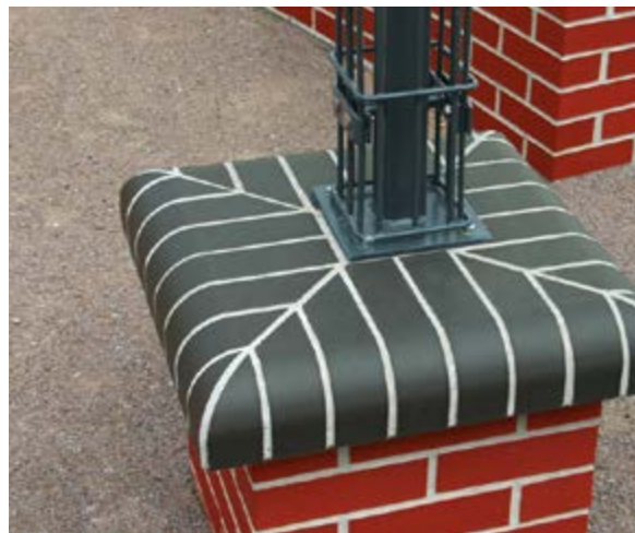
Die von einem Garten- und Landschaftsarchitekten gestaltete Anlage verbindet Ziegelmauerwerk mit einer Pergola-Gitterkonstruktion, getragen von Ziegel-Pfeilern, mit besonders ausgeformten Mauerwerks-Abdeckungen.
