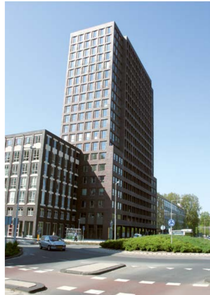
Wohnanlage mit 20 Etagen. Die Ziegelfassaden bestehen nahezu vollständig aus vorgefer- tigten Elementen. Seite 12
