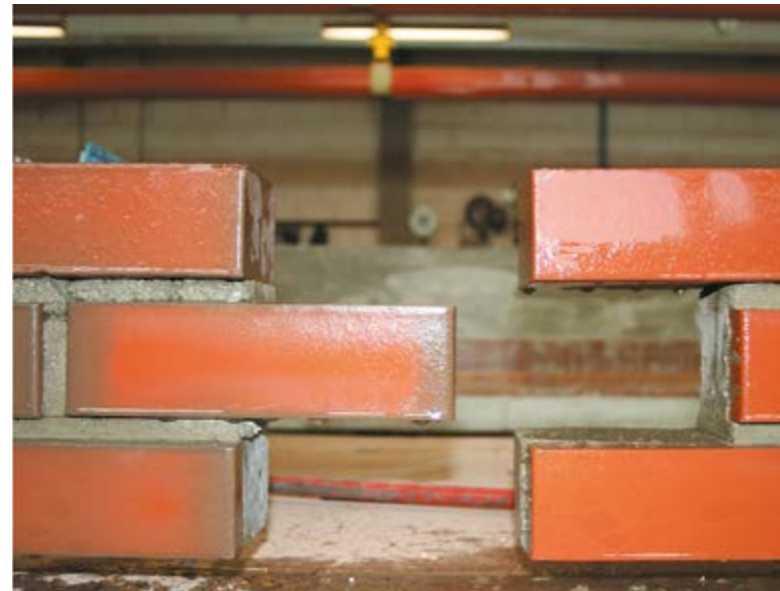
Fensterbank-Rollschicht mit großer Leibungstiefe Dämmung 3,0 cm
