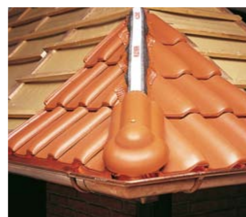
Аккуратным завершением начала или окончания конька шатровой крыши служит заслонка, монтируемая в месте пересечения ребер крыши с коньком.
