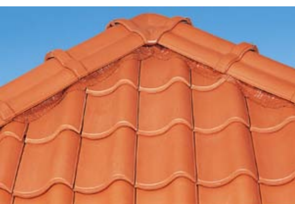
Для конька шатровой крыши существуют т. н. вальмовые заслонки, также изготовленные из обожженной глины.
